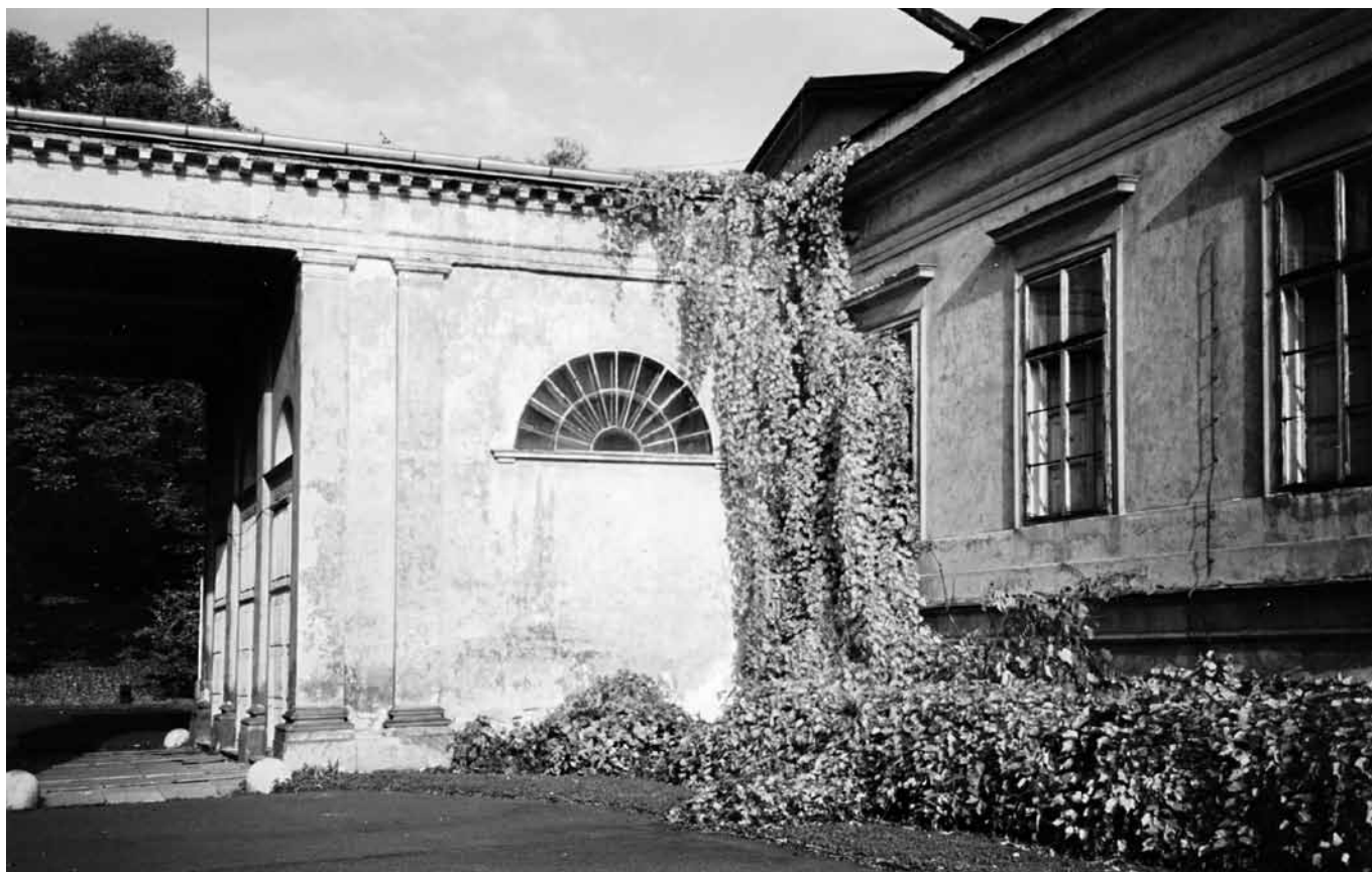
Letohrádek Kinských, hlavní budova Národopisného muzea v její postupné devastaci. Vlhkost stěn je živnou půdou pro cizopasně rostliny. Stav před rekonstrukcí objektu v roce 1997.
