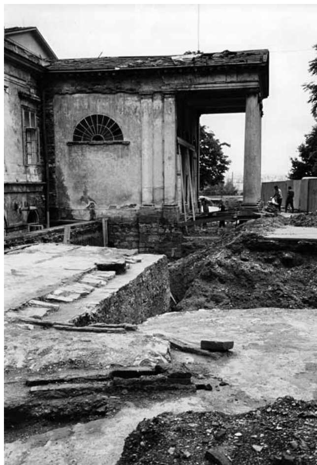
Stavební rekonstrukce Letohrádku Kinských. Pro řádnou obnovu celého objektu bylo nezbytné odkrýt vlhké a rozpadávající se zdivo i v zadním traktu budovy, včetně soutky, sklepů a komunikace nad muzeem. Rekonstrukce objektu v roce 2002. Foto Jiřina Langhammerová.
