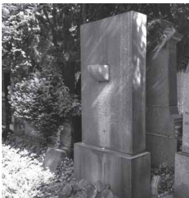
Stav hrobu před opravou
