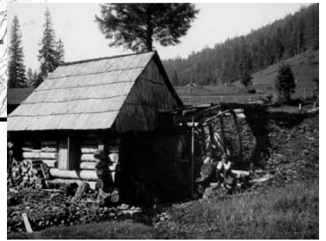
Obr. 14: Objekt valchy z neznámé lokality na Slovensku přiložený k návrhu skanzenu v Šárce (Archiv NM, RNM 1937)
