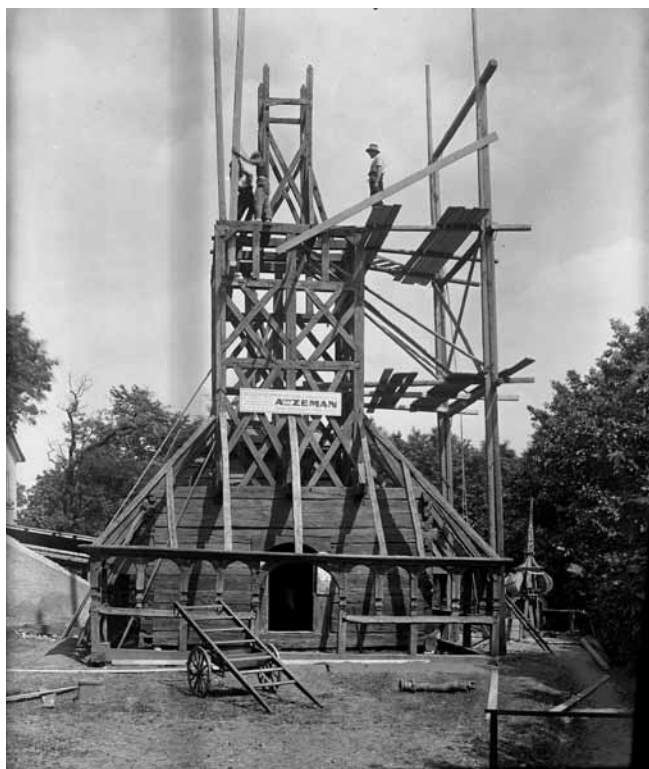
Obr. 6: Stavba kostela sv. Michala v Kinského zahradě v Praze, vnitřní trámová konstrukce hlavní věže. Fotografie Drahomíra Stránská, 23. 8. 1929, Etnografické oddělení Národního muzea, H4-OA-6140.
