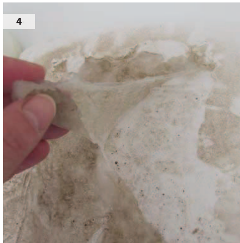
Obr. 3: Nanesení silnější (vlevo nahoře) a tenčí vrstvy (vpravo nahoře), obkladu (vpravo) a suchého škrobu.
