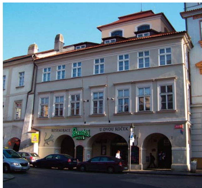
Obr. 5. Bývalý dům U Trnků (dnes U Dvou koček) na Uhelném trhu (Staré Město pražské).
