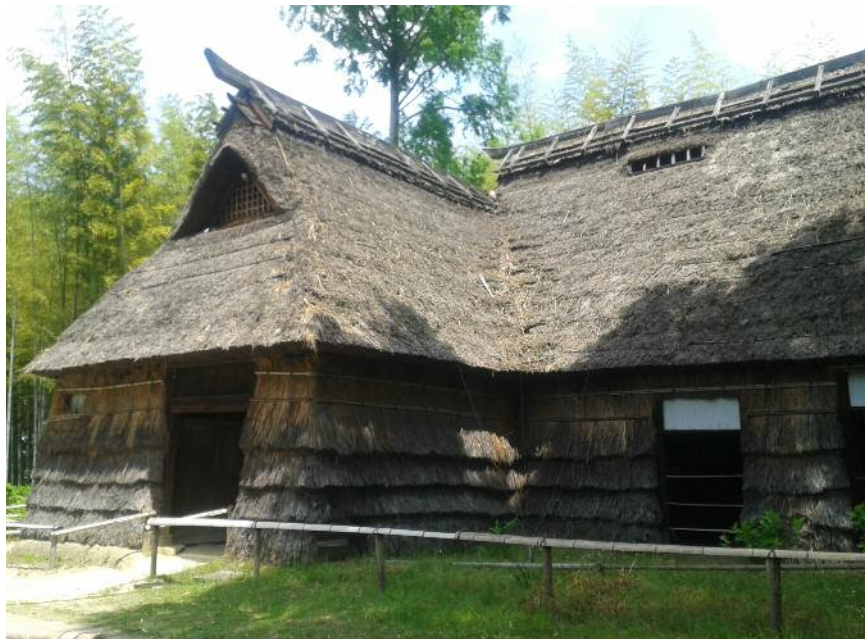
Obr. 3: Dům z oblasti Nagano s kůlovou konstrukcí a stěnami obloženými rákosem – muzeum v přírodě v Osace. Foto: Radek Bryol.
