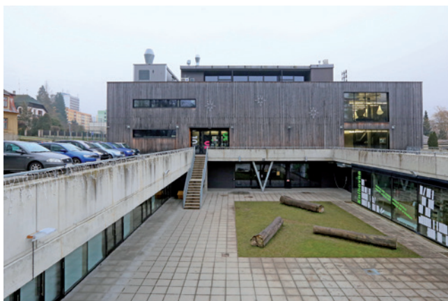
Obr. 25. Kulturní centrum 10 10 10 Vratislavice nad Nisou. Foto Dana Čecháková, 2018.
