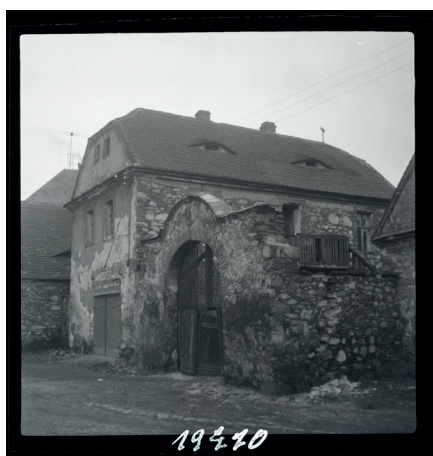
Obr. 27. Opuštěný dům v Souši u Mostu před zbouráním.
