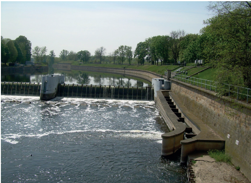
Obr. 8. Současný štěrbinový rybí přechod ze železobetonu, postavený na počátku třetího tisíciletí na novém pohyblivém klapkovém jezu v Terežíně, je průchodný pouze při vyšších průtočných stavech v řece (Just a kol. 2005). Stavbu jezu realizovalo v letech 1972–1976 Povodí Ohře, státní podnik. Foto: N. Milotová (2020).
