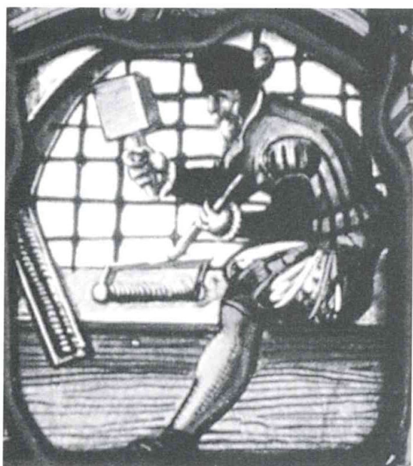
• Obr. 5. Mincíř klopující sloupek střížků sevřený v klopovacích kleštích / malované okno, Schaffhausen 1565 /
