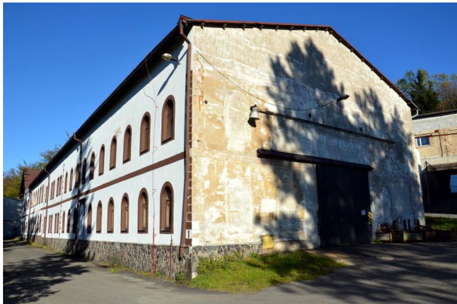
Obr. 4 Na místě dolu Jan v Poušti stojí budova továrny brí Kannebergů na pozamenty (dnes Belet a.s.). V roce 1947 byla nová jáma Jan v Poušti z důvodu existence areálu textilky a malé vodní elektrárny vybudovaná ve svrchní části šachetního stvolu upravena na slepou jámu, která byla otevřenou štolou Laurenci (Vavřinec - dolní). Foto M. Přibíl, 2011.
