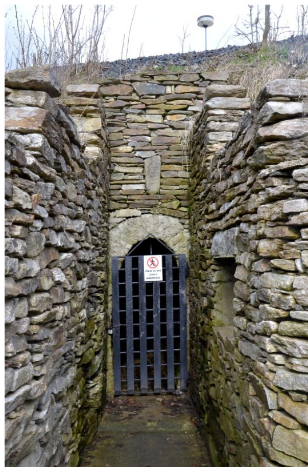
Obr. 15 Nově obnovený portál štoly Antonín . Foto M. Přibil, 2012.
