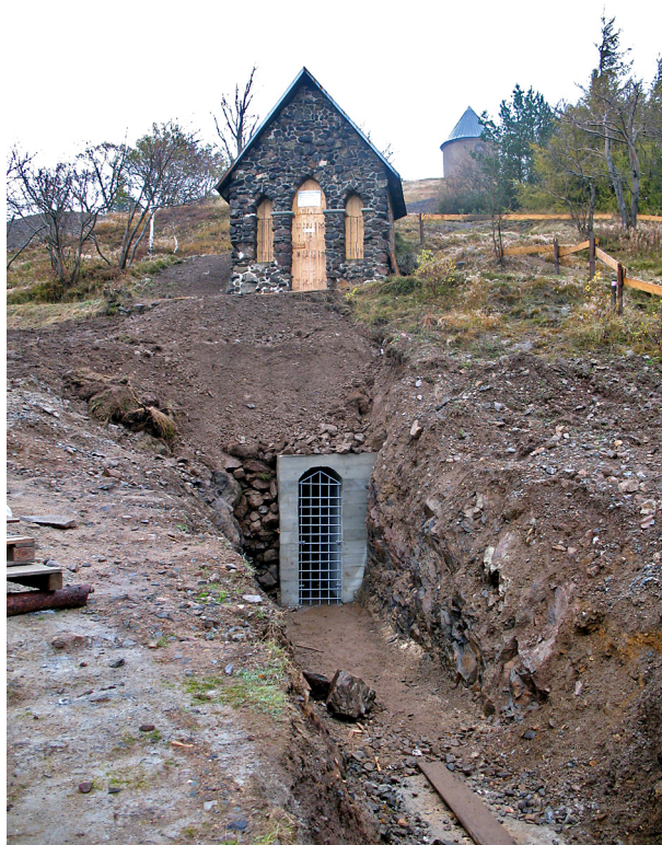
Obr. 2 Zajištění prodlouženého ústí štoly „Země zaslíbená“. Foto P. Bohdálek, 2008.
