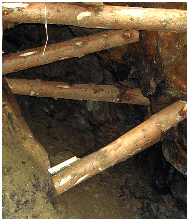
Obr. 3 Provizorně zajištěné podzemní prostory ve štole „Země zaslíbená“. Foto P. Bohdálek, 2008.
