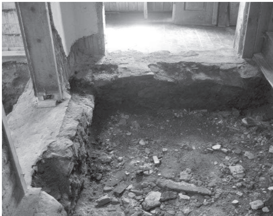
Obr. 3: Sanace chodby, foto: B. Švecová.
