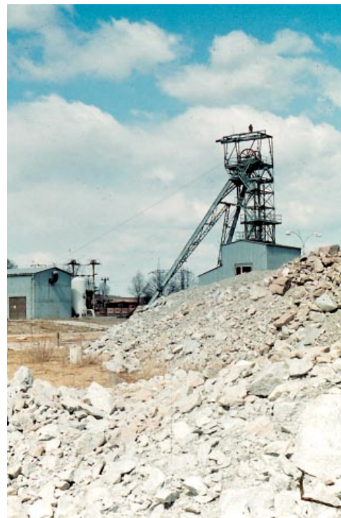
Obr. 3 Těžní věž šachty č. 82 Nahošín s kompresorovnou. Foto S. Klauudy, březen 1988.
