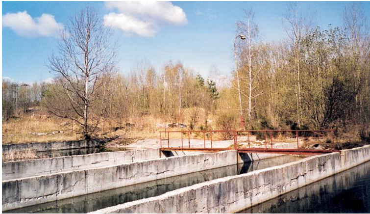
Obr. 8 Nádrže čističky důlních vod v areálu šachty Nahošín. Foto J. Litochleb, duben 2005.
