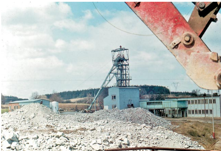
Obr. 2 Těžní věž a provozní objekty šachty č. 82 Nahošín. Foto S. Klauudy, březen 1988.
