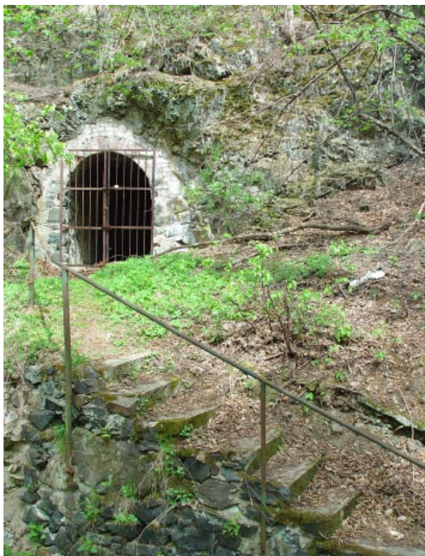
Obr. 4 Ústí štoly č. II na pravém břehu Kocáby pod Chvojnou. Foto A. Švec, květen 2003.
