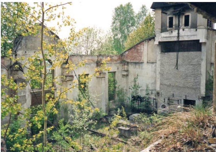
Obr. 35 Vegetací zarůstající pozůstatky budovy úpravny. Foto J. Litochleb, květen 1999.
