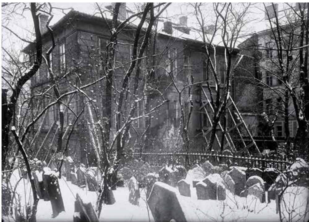
● □ 10: Jan KRÍŽENECKÝ, Všeobecná židovská nemocnice , Praha-Josefov čp. 248, fotografie, 1909–1910; sbírka: Archiv hlavního města Prahy, Sběrka fotografií, sign. XI 4127. Budova je pro statické potíže podepřena, vpravo vzadu nová zástavba Maiselovy (dříve Belelesovy) ulice, uprostřed fotografie u plaňkového plotu poloha nejstaršího hrobu Avigdora Kary.
