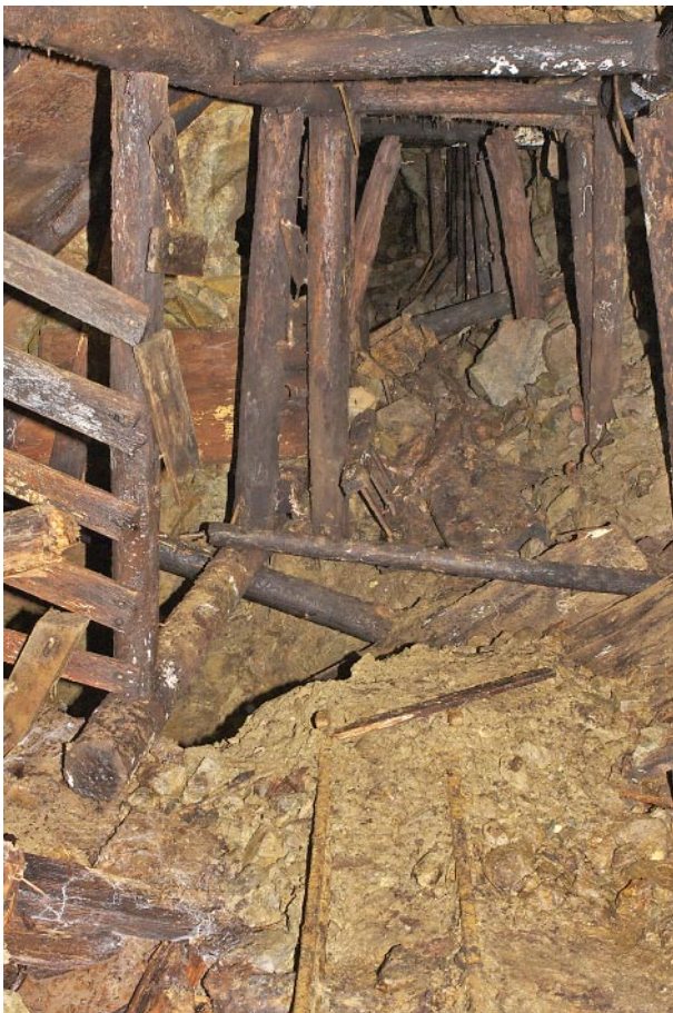
Obr. 1 Směrná chodba po žíle M18 v prostoru s výskytem Bi-mineralizace s hloubením a zbytkem vrátkového škrabáku pro dopravu rubaniny. Foto archiv autorů.
