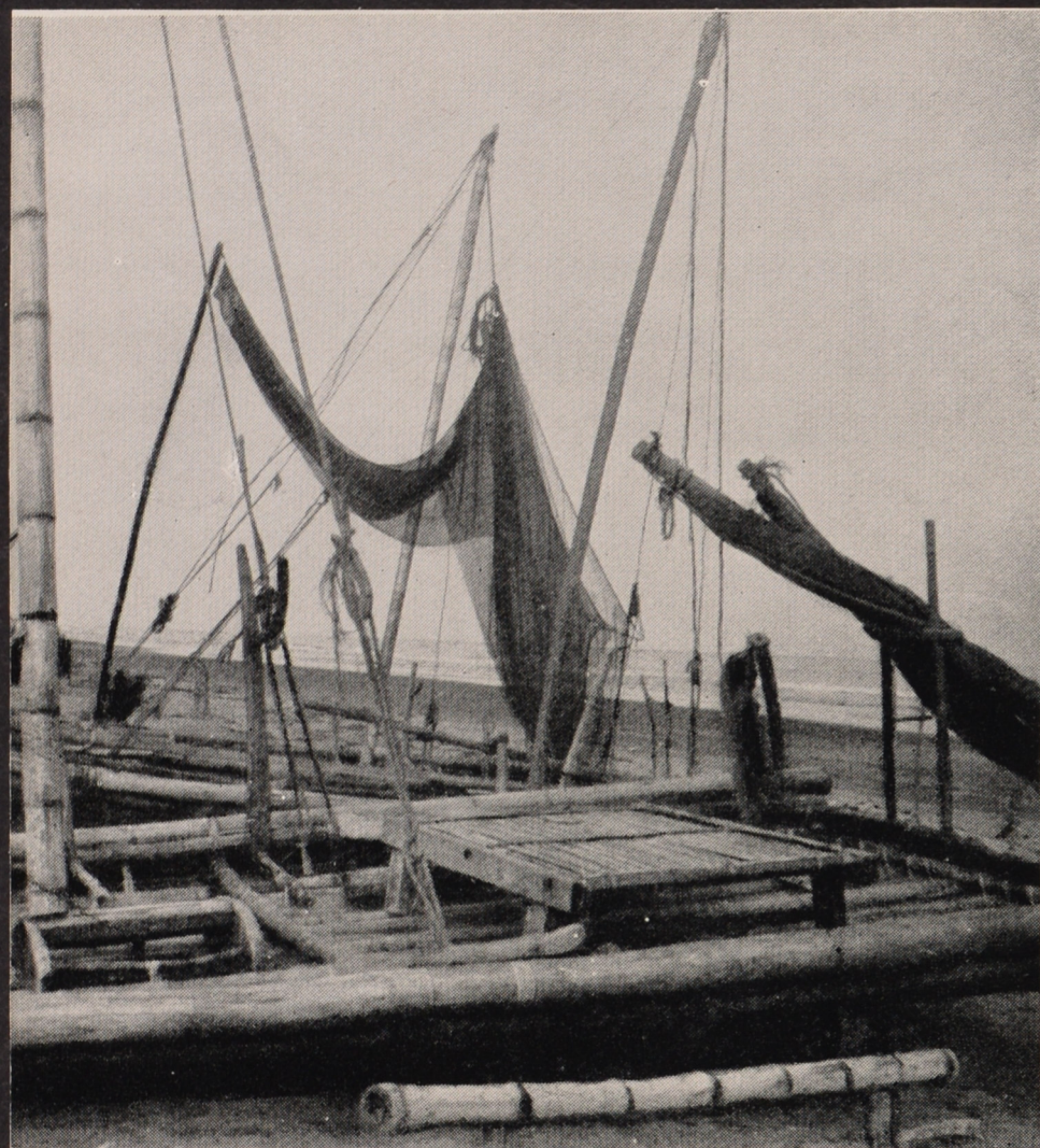
Heck mit Mast und Plattform
