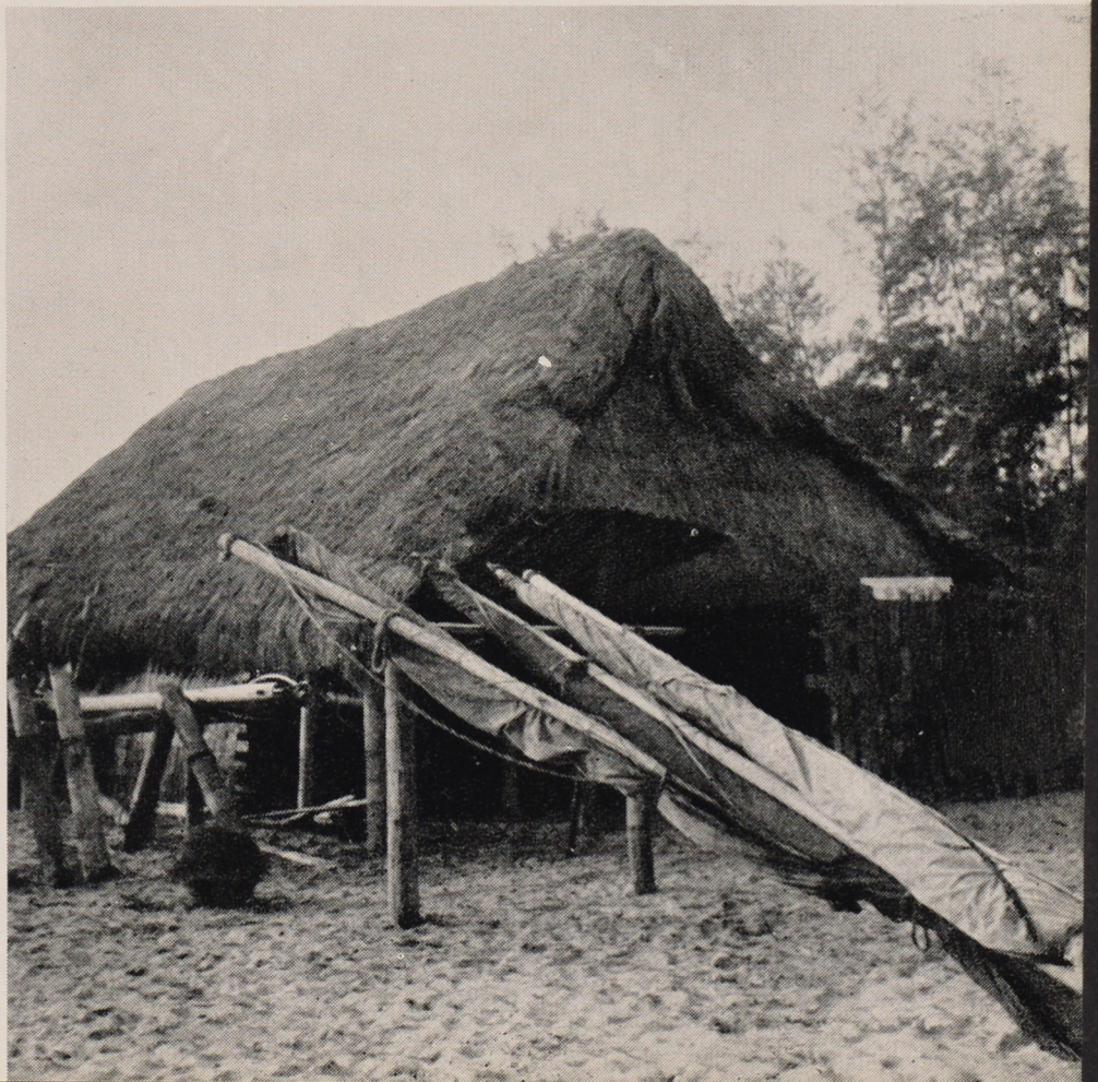
Aufbewahrung der Mast- bäume vor dem Schuppen
