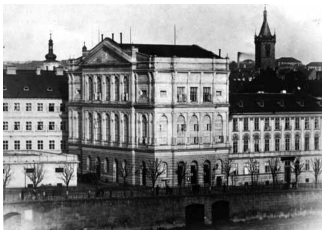
Obr. 2. Budova Prozatímního divadla
