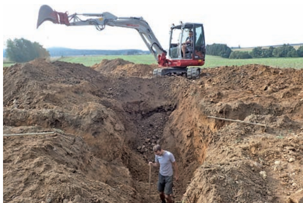
Obr. 7. Výkopové práce v místech staré důlní šachty poblíž Starohorského rybníka u Ratibořských Hor, srpen 2017. Foto: P. Černý.
