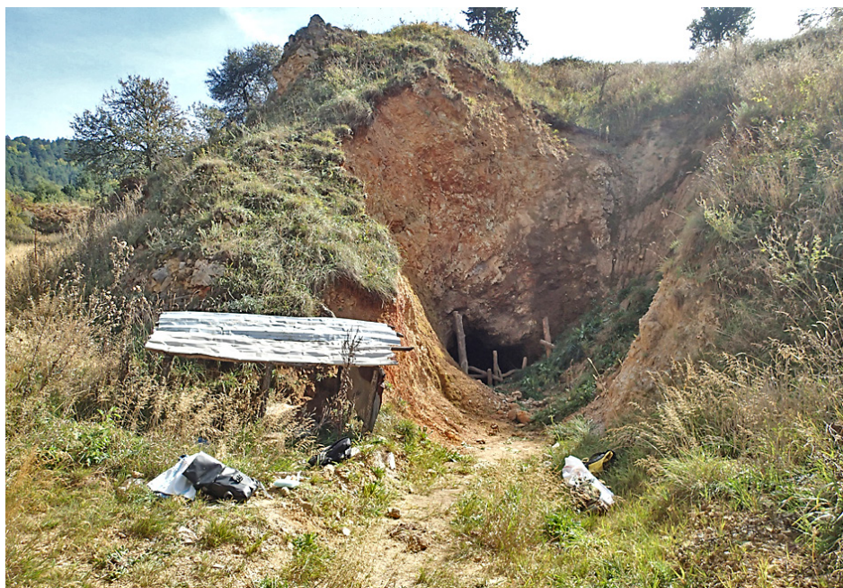
Obr. 9. Ústí opuštěné štoly č. 21 na lokalitě Crven Dol, naposledy vyzmáhané pro těžbu loránditu (sulfidu Tl a As), v severní části rudního revíru Allchar, severní Makedonie. Foto: J. Sejkora.
