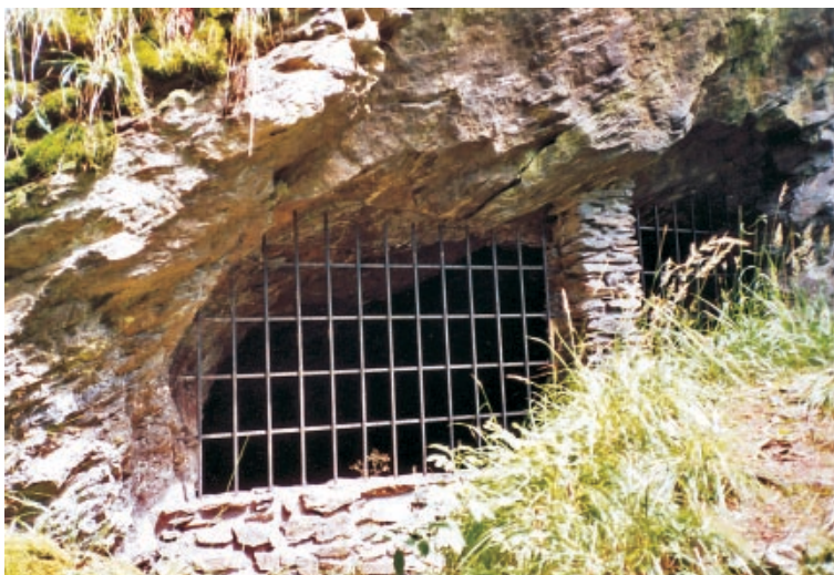
Obr. 4 Zabezpečené staré dobovky v údolí Zlatého potoka v blízkosti štoly Josef. Foto J. Litochleb, srpen 2009.
