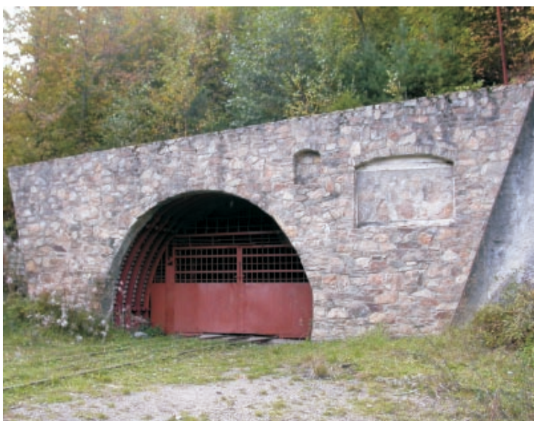
Obr. 6 Ústí průzkumné štoly Naděje jv. od Kašperských Hor. Foto B. Šreinová, září 2007.
