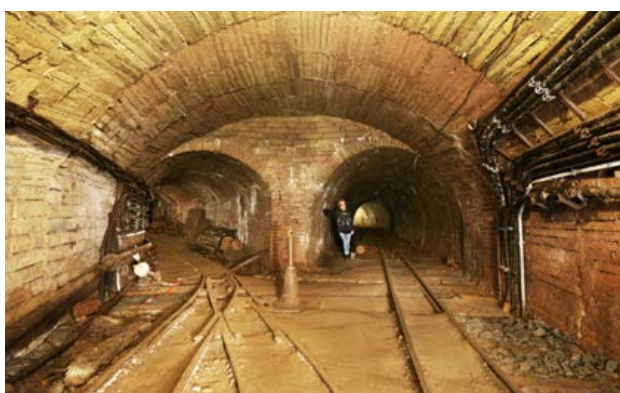
Obr. 60 Tvárnicevá výstuž na 16. patře dolu Skalka. Archivní foto, M. Korba.
