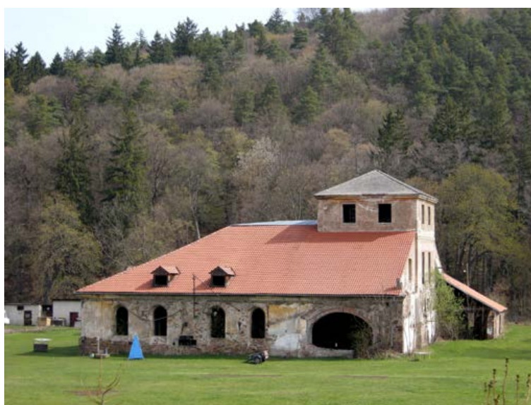
Obr. 30 Vysoká dřevouhelná pec pod rybníkem Pecovák v Jincích z let 1810 - 1874. Foto J. Litochleb, duben 2012.
