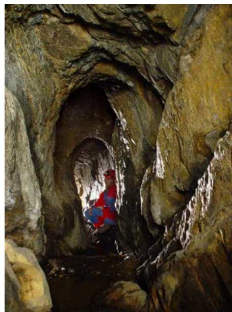
Obr. 18 Veřejitý profil s. části technologické štoly „V Pekle“ u Klínce. Archivní foto, M. Korba.
