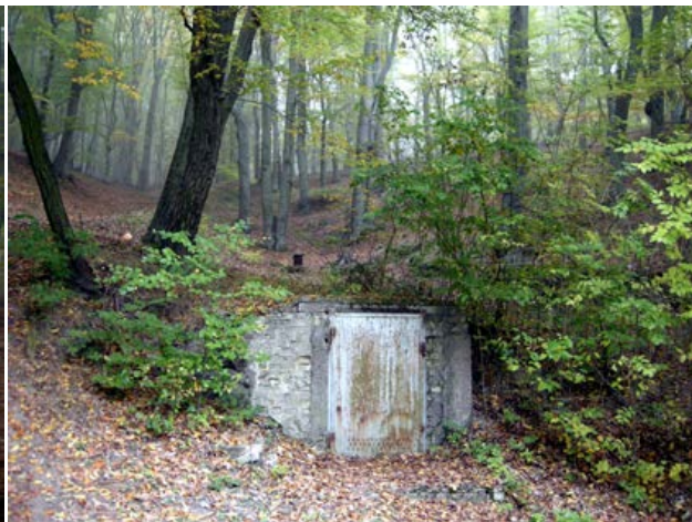
Obr. 27 Ústí odvodňovací štolky z 16. století u Nové Vsi pod Pleší. Foto J. Litochleb, říjen 2010.
