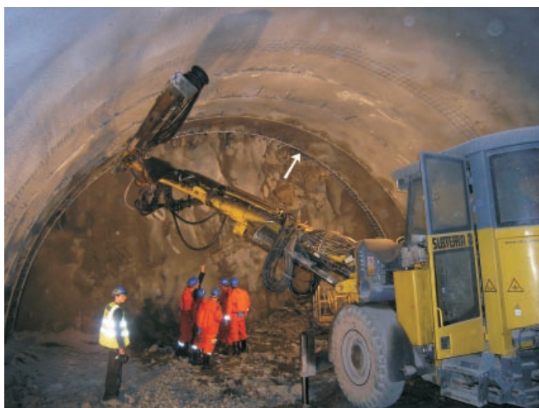
Obř. 1 Čelba severního tunelu ve staničení 988.1 m, vstup do staré štoly vyznačen šipkou. Foto HBZS Praha, květen 2006.
