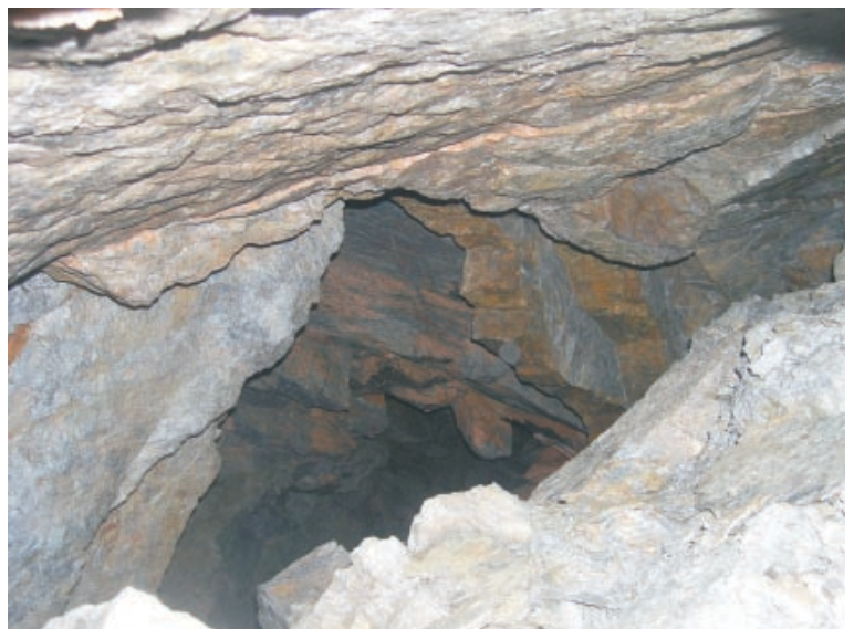
Obr. 6 Pohled na zával ve 12 m od vstupu ze stropu tunelu do pokračování štoly k SV. Foto HBZS Praha, květen 2009.
